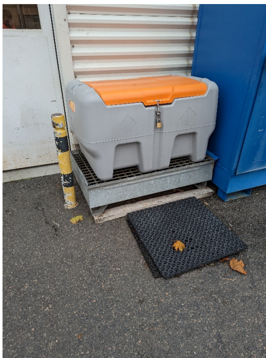
Figure 36 : Vue de la cuve d'appoint gazole de 200 L du bâtiment 0103
