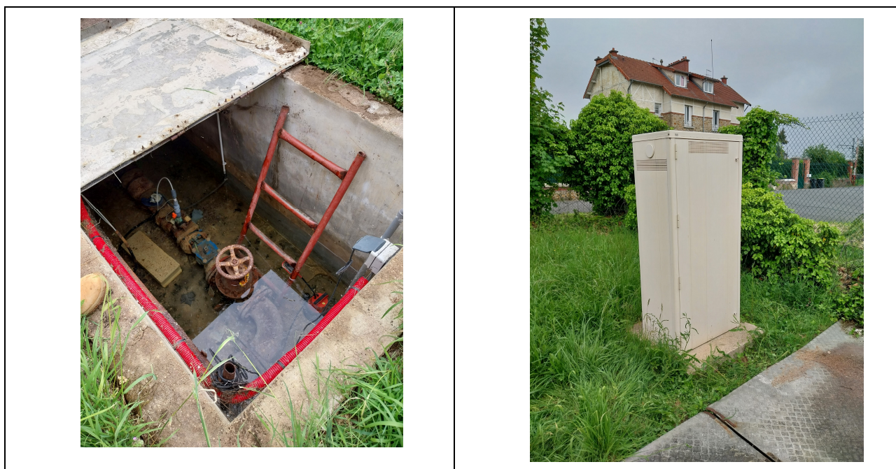
Figure 43 : Compteur, arrivée d'eau du site et station de chloration
